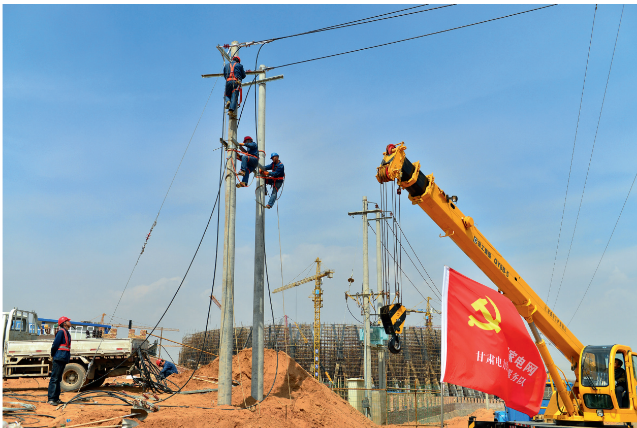
A 农网改造升级施工现场。
