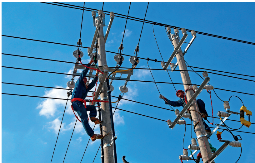
▲ 按照“四个一”标准建设农网工程。图为同杆架设高低压线路。摄影 / 孙家宽
