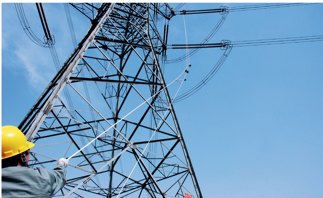
▲ 国网河北检修公司员工正在检修线路。
