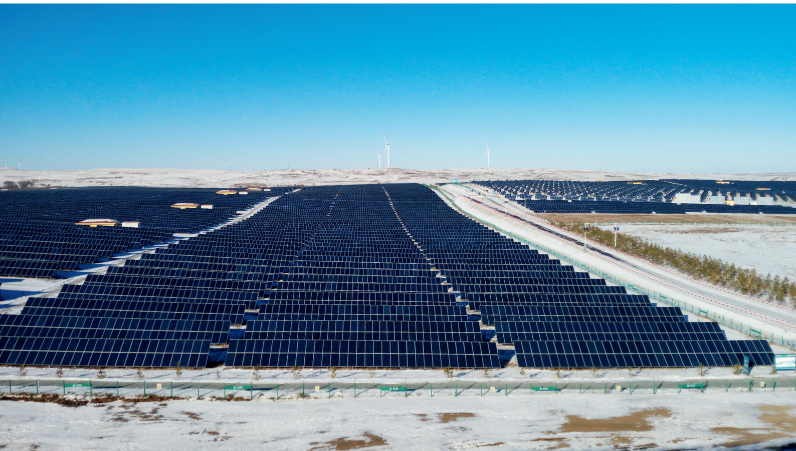
▲ 张北国家风光储输示范工程。摄影 / 王为民
