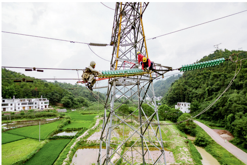
▲ 电网工程施工现场。摄影 / 李彦佐
