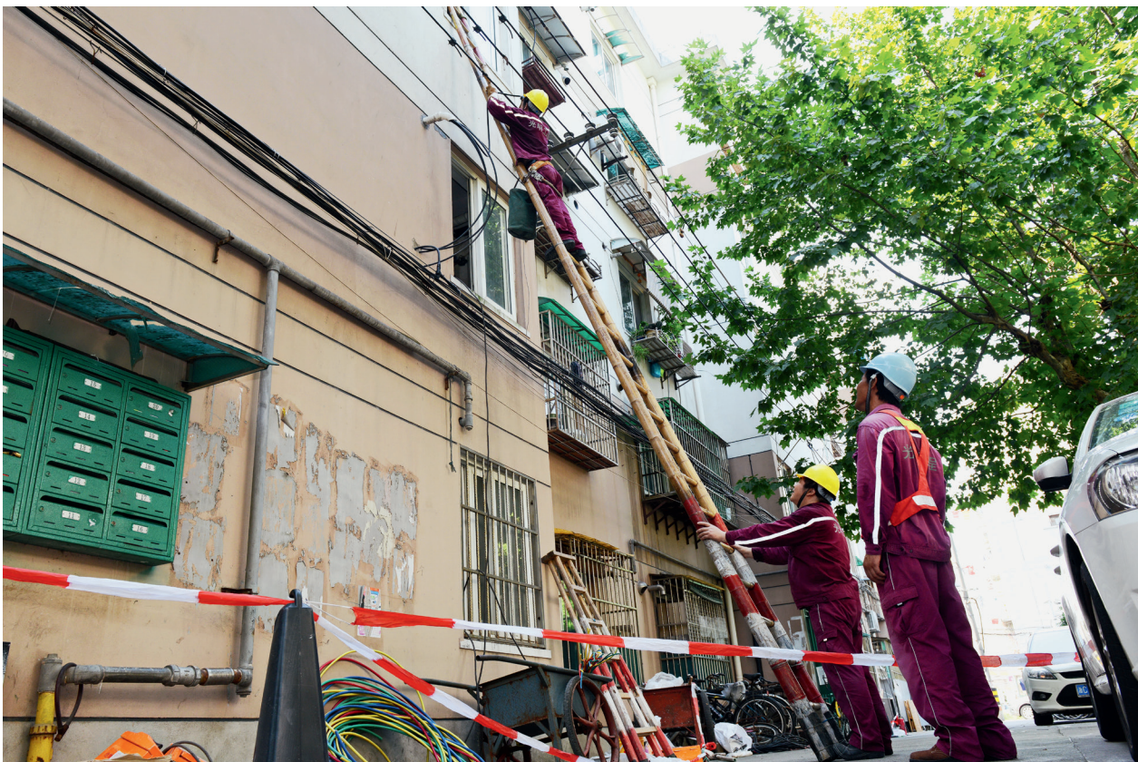
A 上海鞍山新村“光明工程”施工中。摄影 / 傅为民
