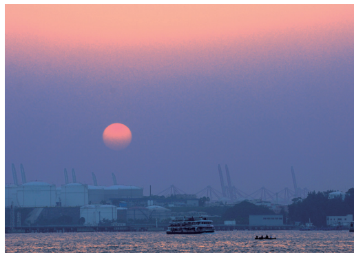
>> 2013年10月25日，福建厦门，华夏国际电力发展有限公司的火力发电厂远眺。
