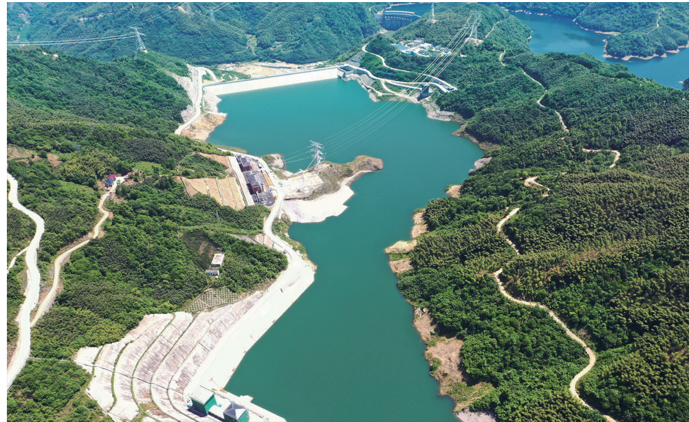
&gt;&gt; 安徽金寨抽水蓄能电站。
