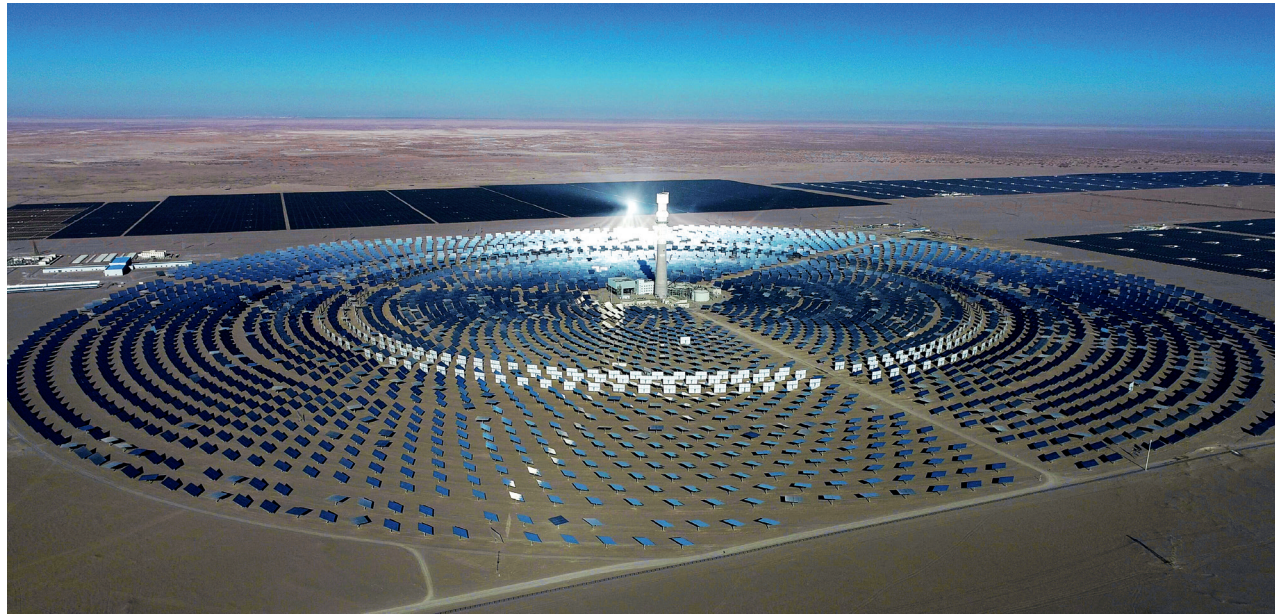
&gt;&gt; 青海海西格尔木光热电站。
