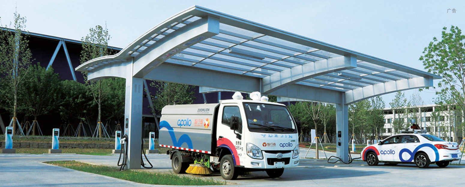
许继雄安新区市民中心停车场光储充一体化充电站项目
