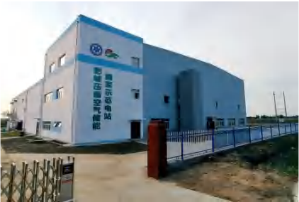
>> 肥城盐穴压缩空气储能电站1号发电机启动运行，标志着国际首套盐穴先进压缩空气储能电站发出第一度电。（摄影 / 崔璨）
