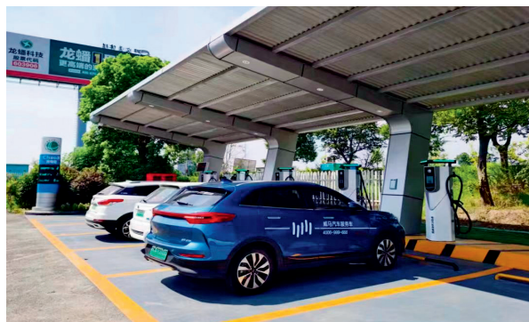
>> 南瑞集团承建的江苏省新能源汽车充电设施运行监管平台、承建的江苏泰州宜堡服务区ChaoJi充电站。
