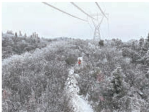
输电线路可能会在特定气象条件下形成覆冰，这取决于多种气象因素和环境条件。覆冰形成的必要气象条件包括较高的空气平均相对湿度（ $\geq 85\%$ ）、较大的风速（ $\geq 1$ 米/秒）、较低的气温及导线表面温度（ $-5^{\circ}\text{C}\sim 0^{\circ}\text{C}$ ）等。
